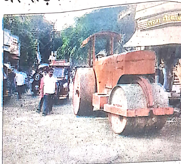
शहर में राम के चौराहे के पास सड़क निर्माण के लिए आधार तैयार करता रोड रोलर। स्रोत : विभाग
